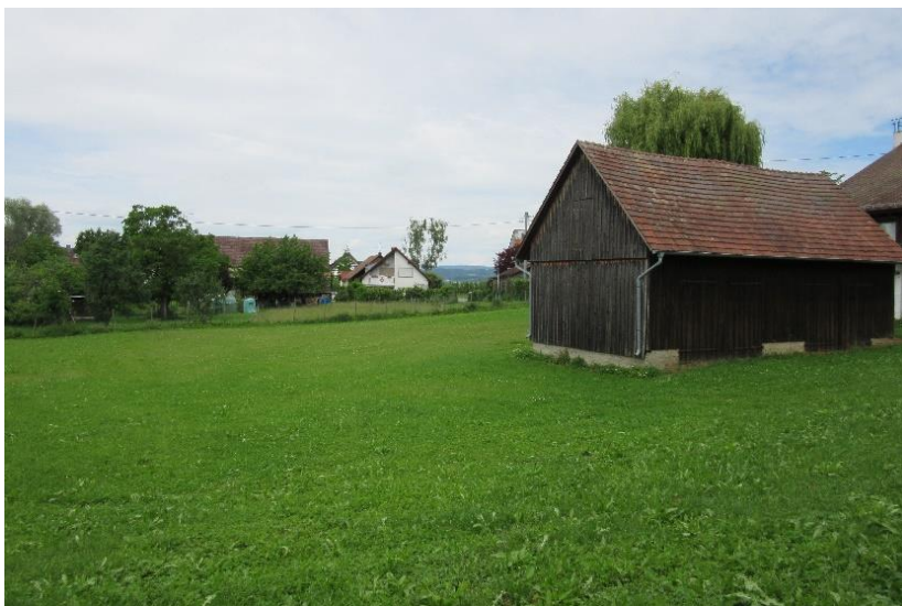
Abbildung 5: Bestandsscheune und Freifläche Bestand, Ansicht von Süden
