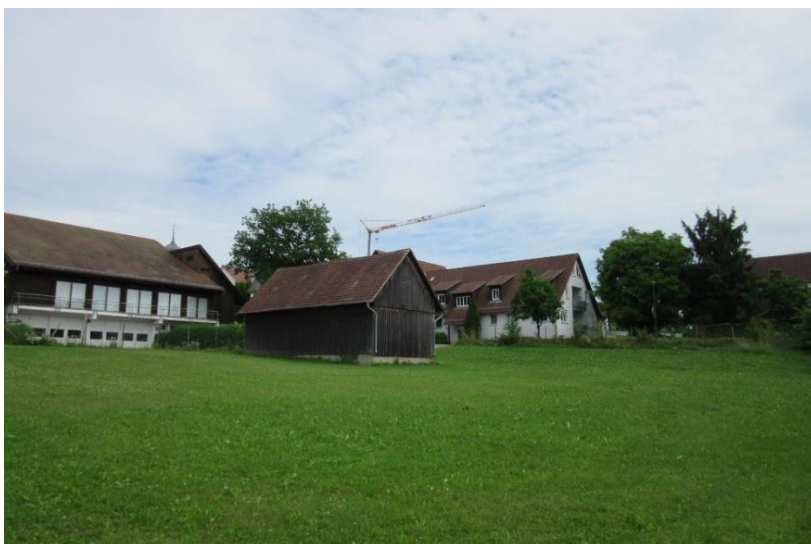
Abbildung 6: Bestandsscheune und Freifläche Bestand, Ansicht von Nord-West
