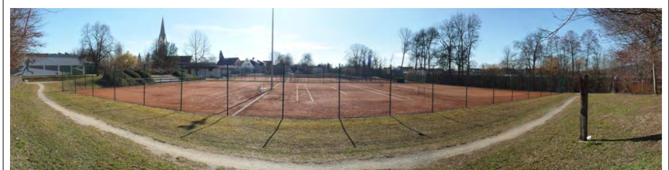
Blick auf die derzeitigen Tennisanlagen aus nördlicher Richtung
