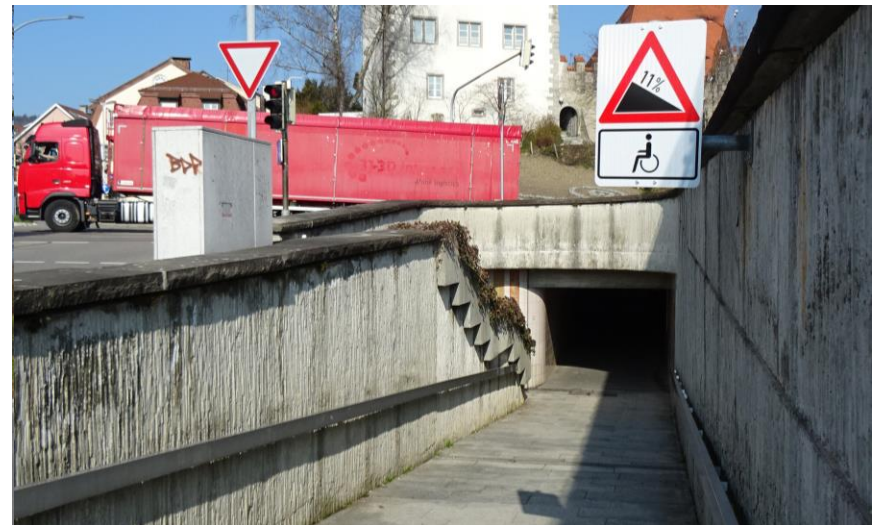
Unterführung B 33/Am Stadtgraben
