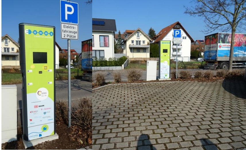
Ladestation für zwei Elektrofahrzeuge
