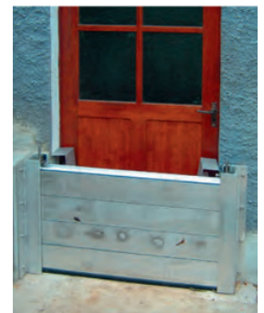
Teilmobile Türsperrung (Foto: BMUB, 2016)
