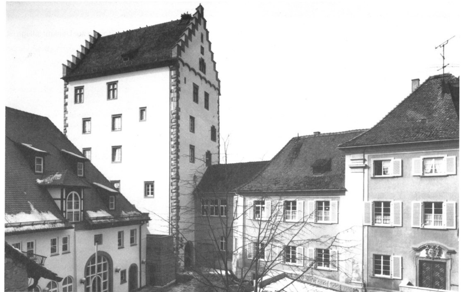
Abb. 2 Bischofsschloß und Schloßscheuer nach der Sanierung
