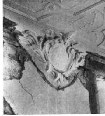
Abb. 27 Das Wappen während der Sanierung, vor Abnahme des unteren Teiles
