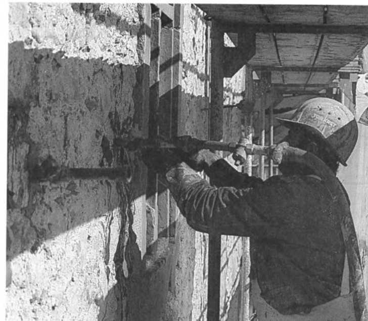
Verpressungsarbeiten am Turm 1984
