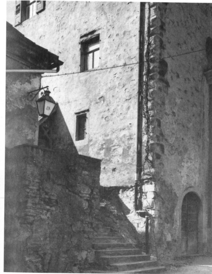
Abb. 11 Markdorf, Buckelquader in mittelalterlicher Bautradition an der Nordostecke des Gebäudes.
