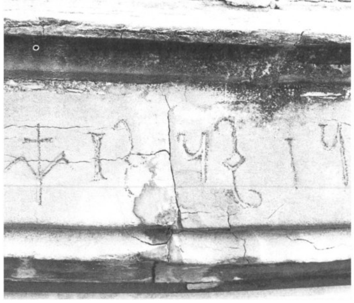
Abb. 6 Steinmetzzeichen und Datumsinschrift auf einem Fenstersturz an der Südseite im 2. Obergeschoß des Bischofsschlosses
