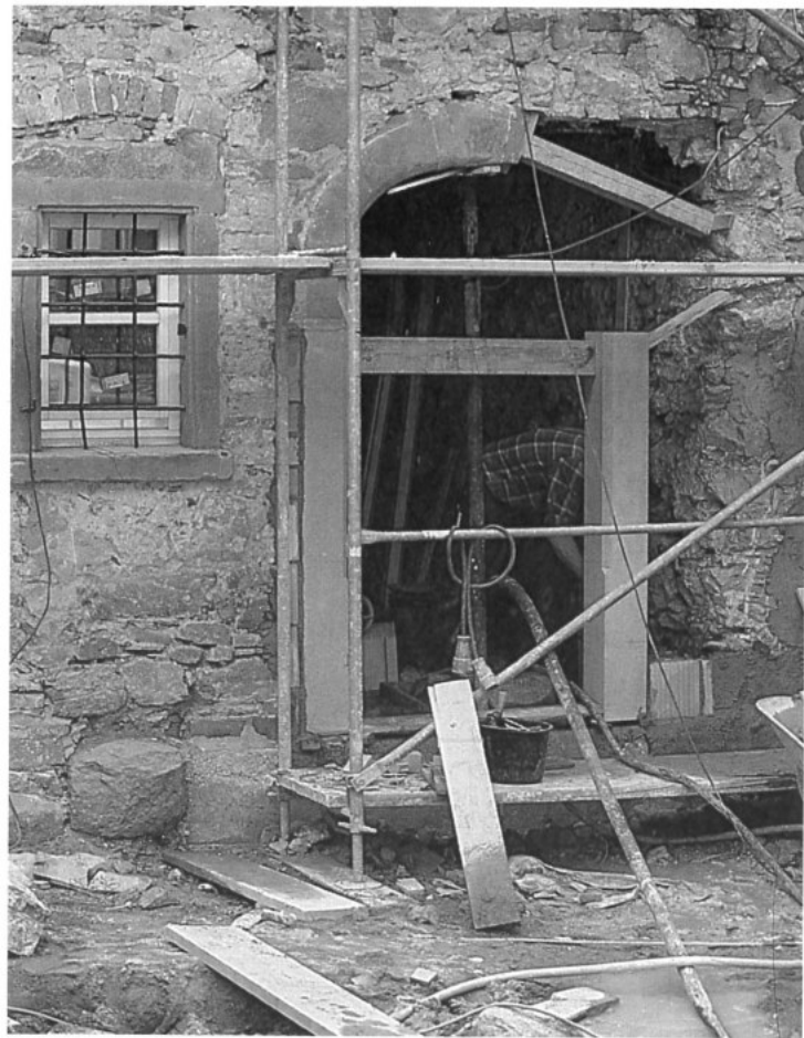
Arbeiten am Torbogen 1984
