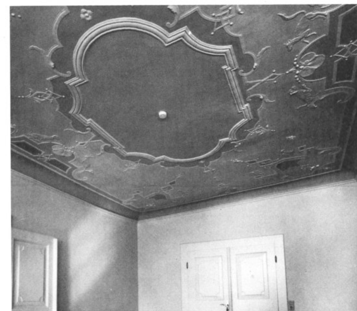
Abb. 32 Das Tierfabelzimmer im 3. Obergeschoß des Bischofsschlusses nach der Sanierung
