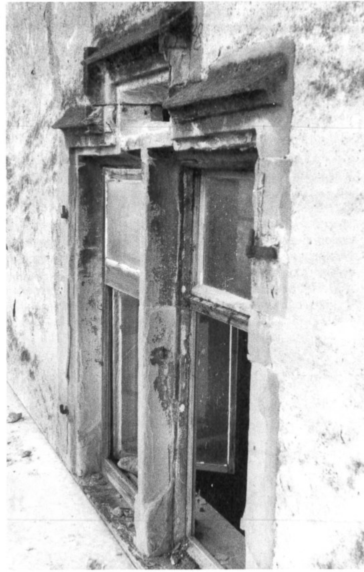
Abb. 10 Staffelfenster an der Nordseite im 2. Obergeschoß des Bischofsschlusses vor der Sanierung
