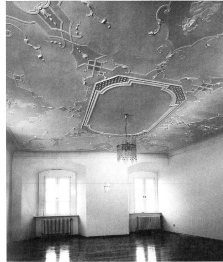
Abb. 29 Der Jahreszeitensaal im 3. Obergeschoß des Bischofsschlosses nach der Sanierung
