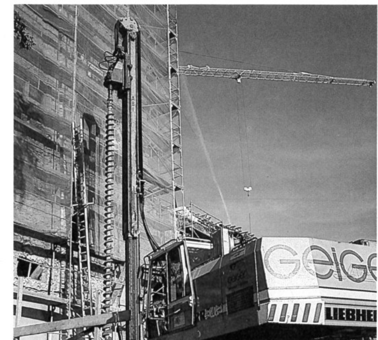
Bohrungen für den „Berliner Verbau“ 1983
