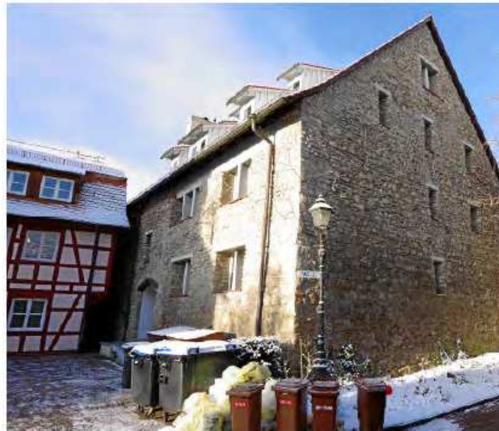
Abb.32 Ansicht Schloßscheuer Nordostfassade
