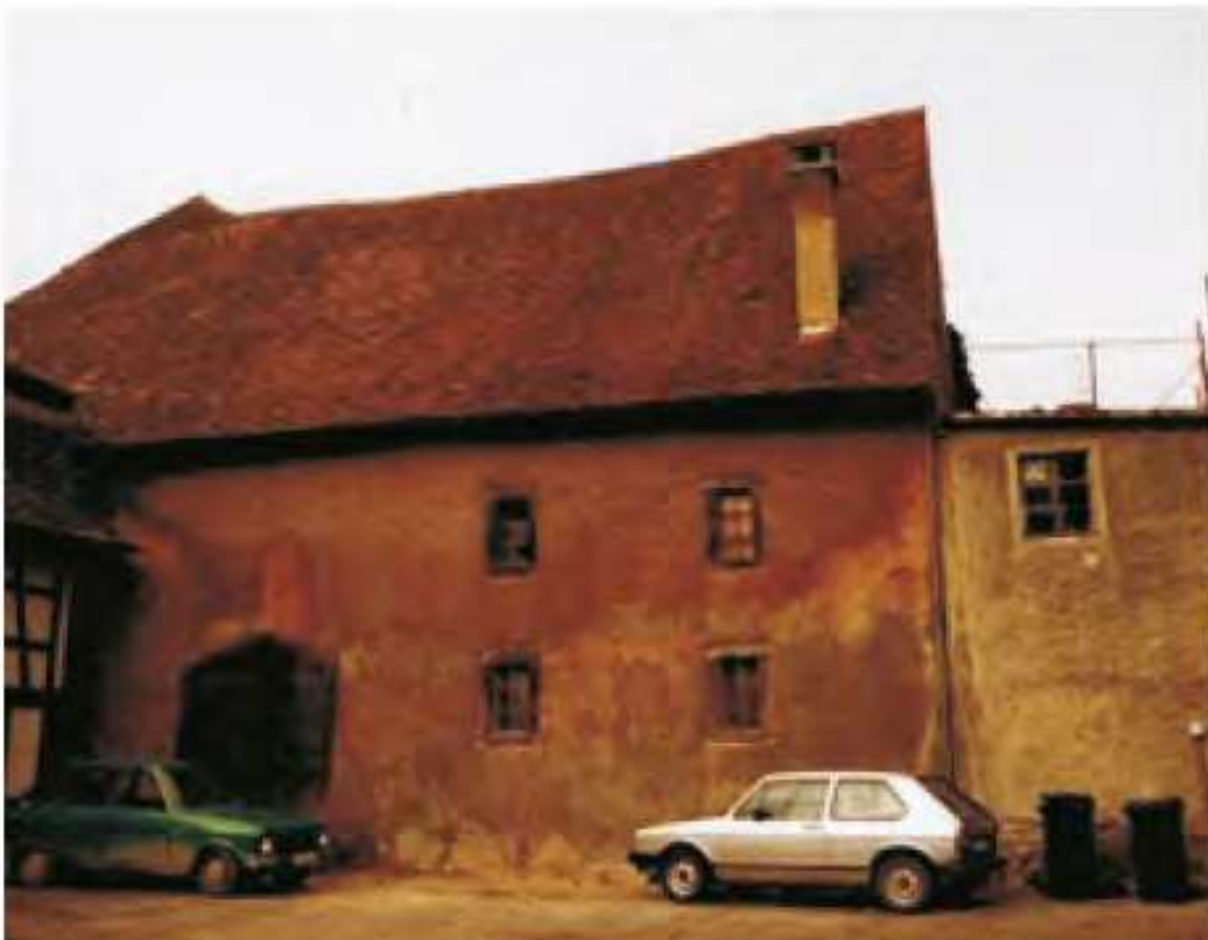
Abb. zeigt geschlämmte/verputzte Außenmauer der Schlossscheuer
