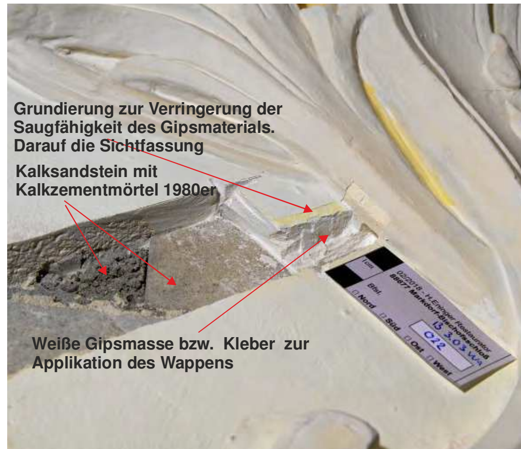
Abb.12 Bfst. B022R - Kalksandsteinwand der 1980er mit z
