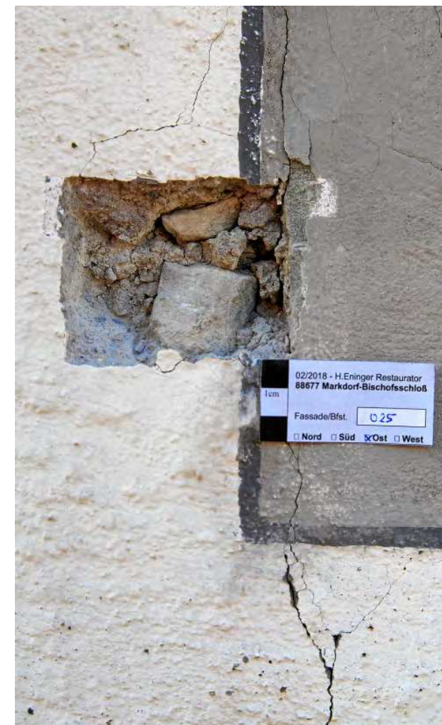
Abb.5 Bfst. B025 (T222) Wandanschluß zu Sandsteinfensterrahmung.
