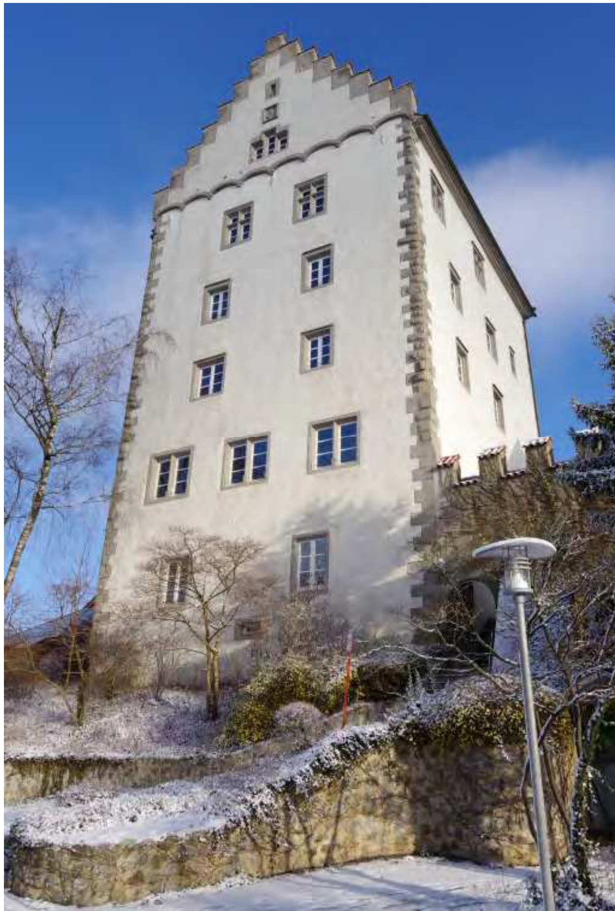
Abb.3 Ansicht Bischofsschloß Südostfassade
