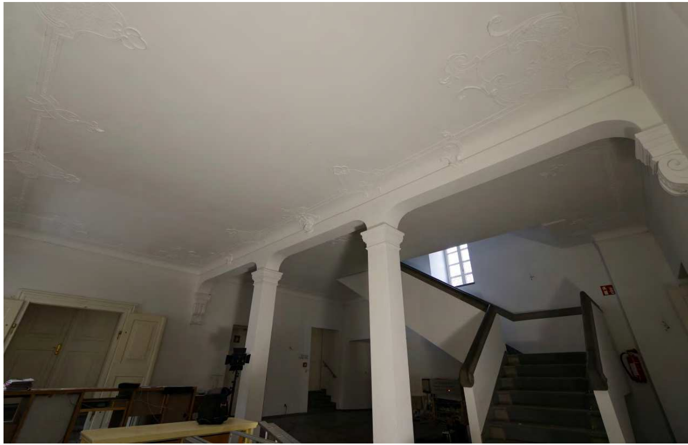
Abb.21 - Neues Schloß - Raum N0.01, Stuckdecke der 1980er auf moderner Betondecke, Blickrichtung Südwest
