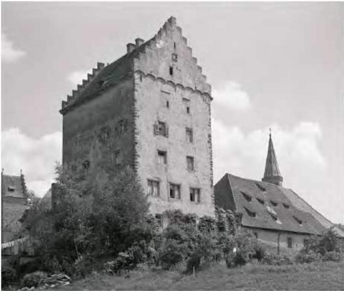
Abb. zeigt geschlämmte/verputzte Stadtmauer an Schlossscheuer
