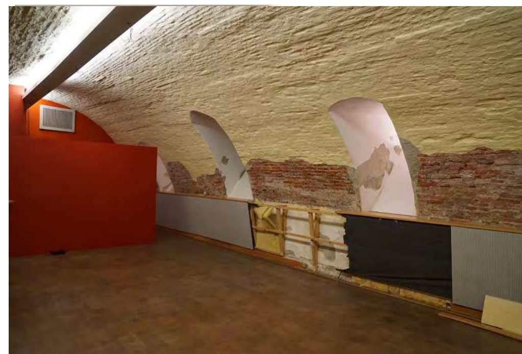
Abb. zeigt verputzten Gewölbekeller
