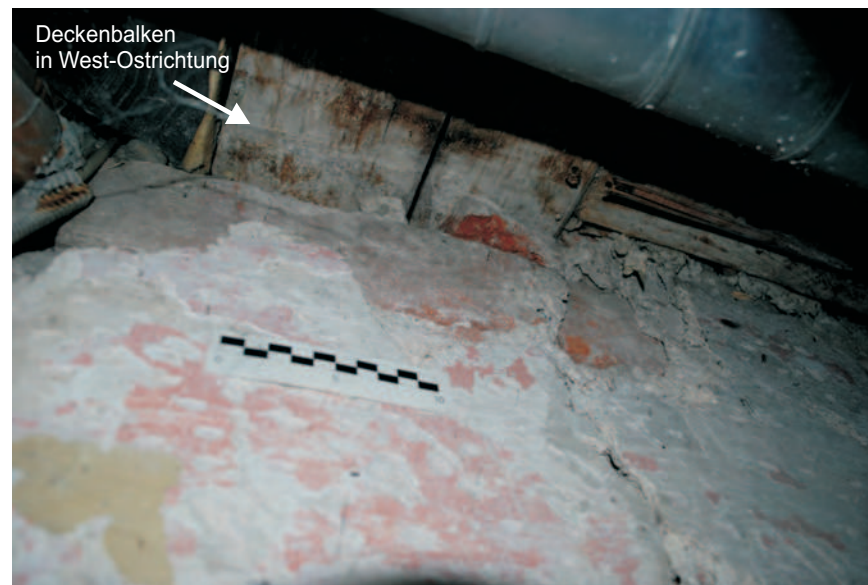
T 410 - Bereich Decke, Auflagerbereich westl. Außenwand
