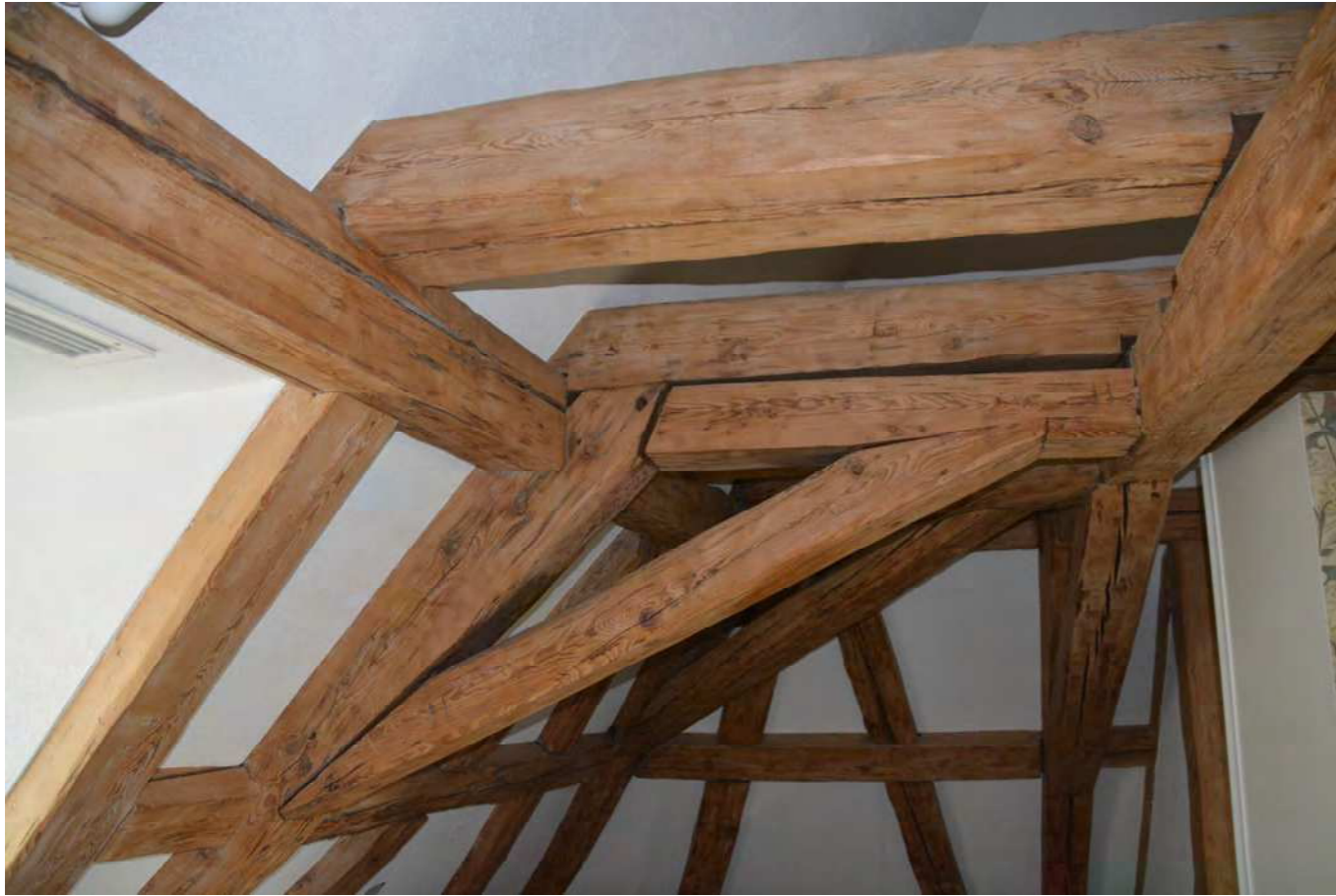
Bild 01, Neues Schloss DG, Kontaktverbindungen 01
