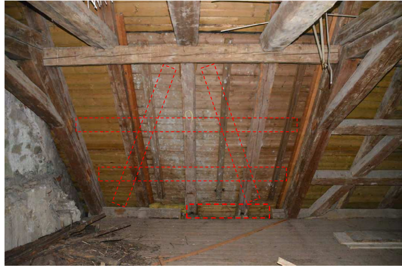
Bild 09, Turm DG 02, Längsverband Nord Ost fehlt
