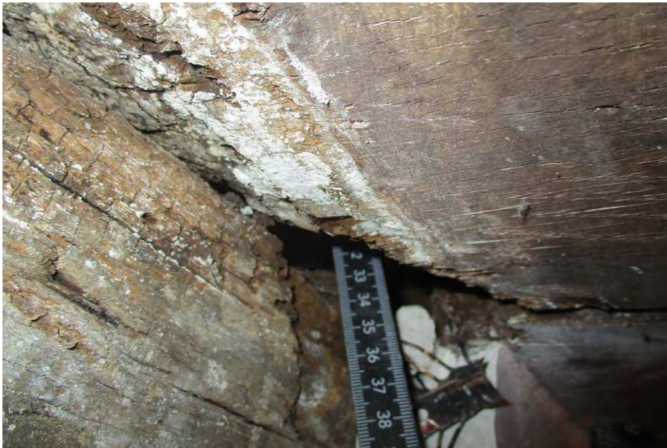
Bild 21, EG01, Raum B 0.04 Holzfeuchte > 19%
