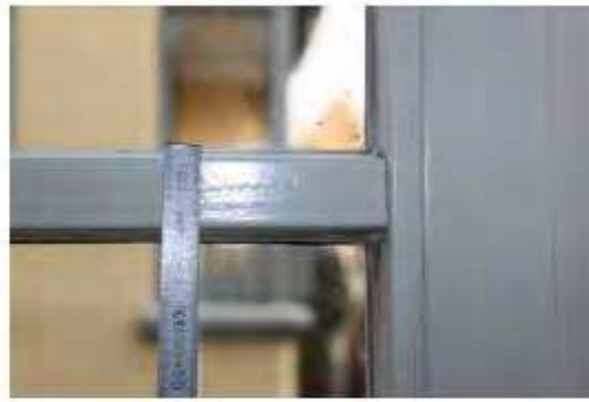
Breite Sprossen, doppelt so breit wie es Fenster in diesem Gebäude eigentlich aufweisen sollten.
