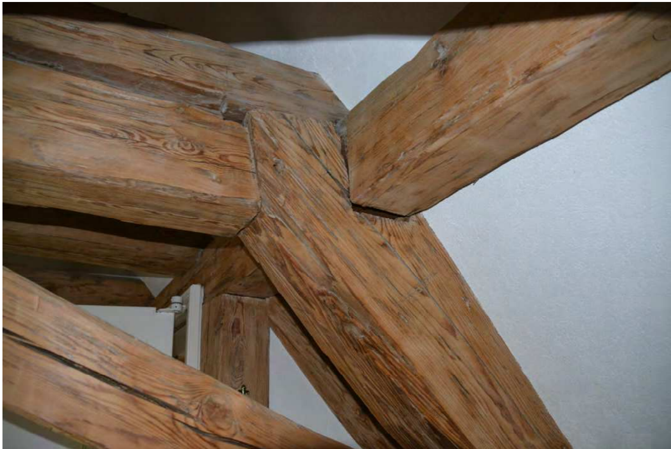
Bild 02, Neues Schloss DG, Kontaktverbindungen 02
