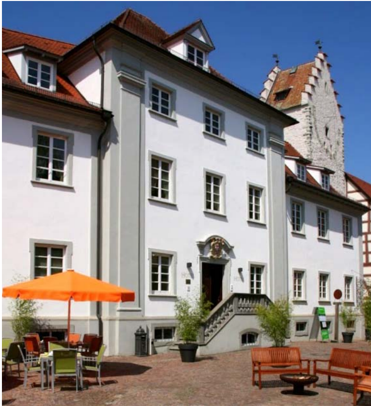
Mittelbau des Neuen Schlosses, Blick nach Nordwesten (Foto LAD Tü)
